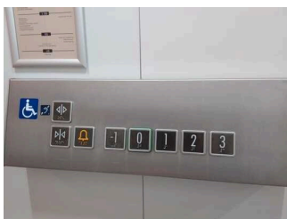
Aufzug von Ebene -1 bis 3
